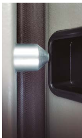
Antipalanca y junta acústica
